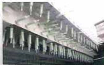
③穿孔→台座取付→断面修復注入
