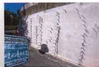
③台座取付→ひび割れ注入
