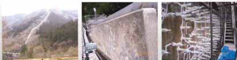
後埋モルタル損傷状況
