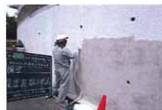
①サンディング 劣化状況の確認
