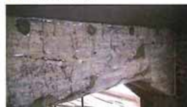
① サンディング後劣化状況の確認
