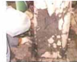
②欠損部の補修
