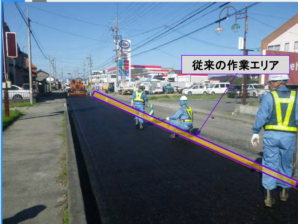
乳剤散布直後の状況
