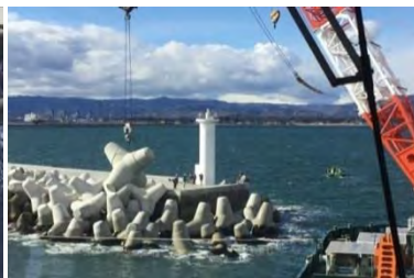
⑥写真画像から得られた位置座標を目標 にブロックを誘導して据付 (ICT施工)
