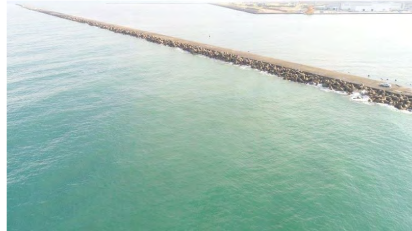
A港防波堤：UAVによる空撮写真
