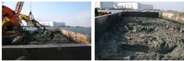
バックホーによる攪拌状況      攪拌終了後の状況
