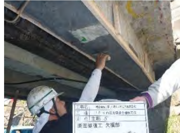
②-2 断面修復部
