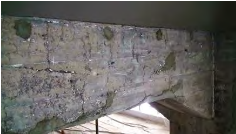
①-1 サンディング後劣化状況の確認
