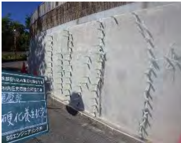
③-3 台座取付→ひび割れ注入
