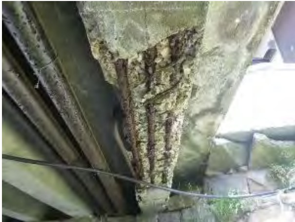
②-1 着工前 劣化状況の確認
