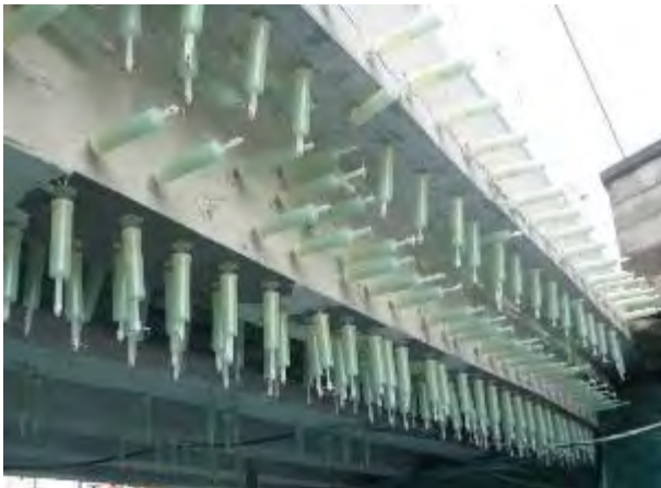
②-3 穿孔→台座取付→断面修復注入
