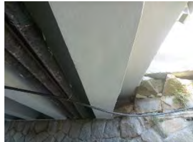
②-4 保護ライニング後完了
