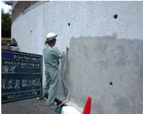
③-1 サンディング 劣化状況の確認
