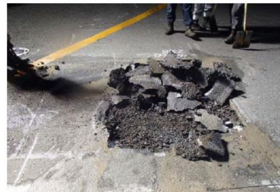
水（雨水や地下水）による剥離由来の破損事例
