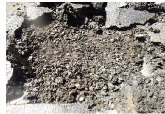
水（雨水や地下水）による剥離由来の破損事例
