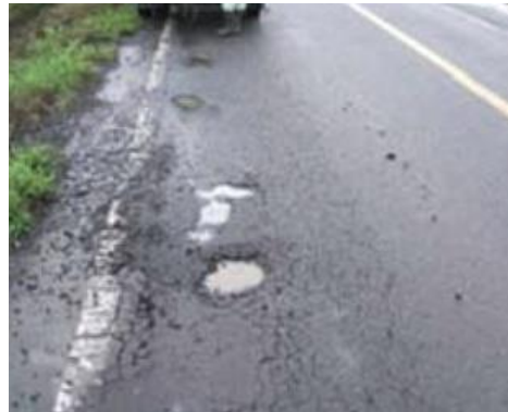
舗装表面の「見える」損傷
