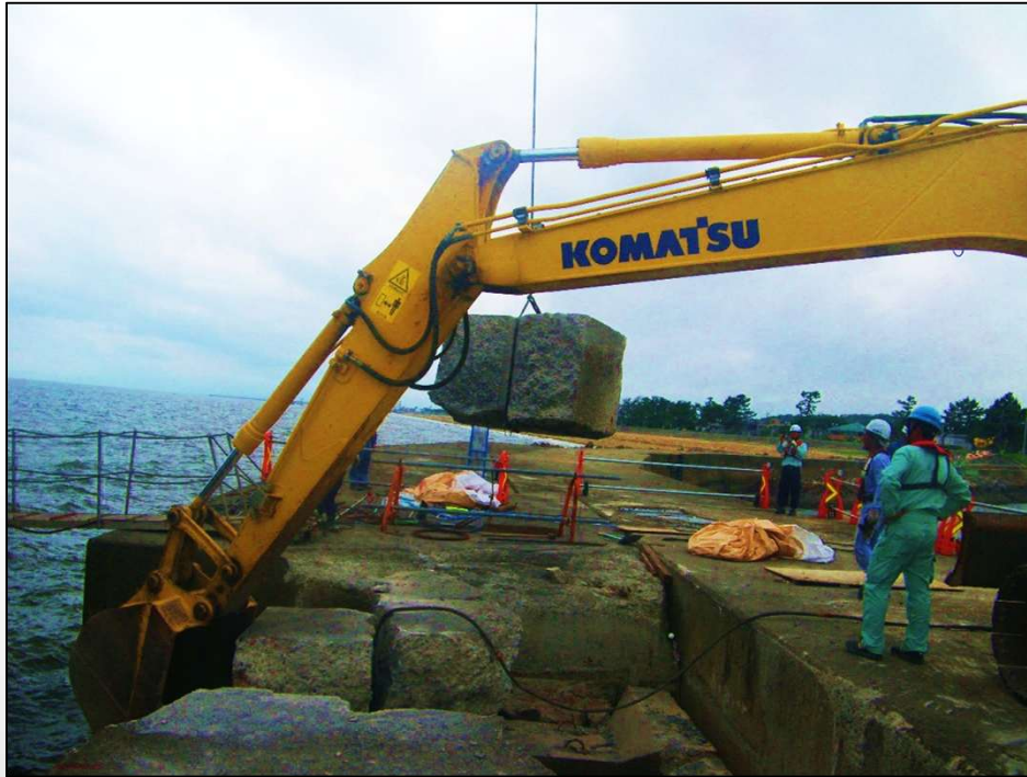
破砕された コンクリートの引き出し
