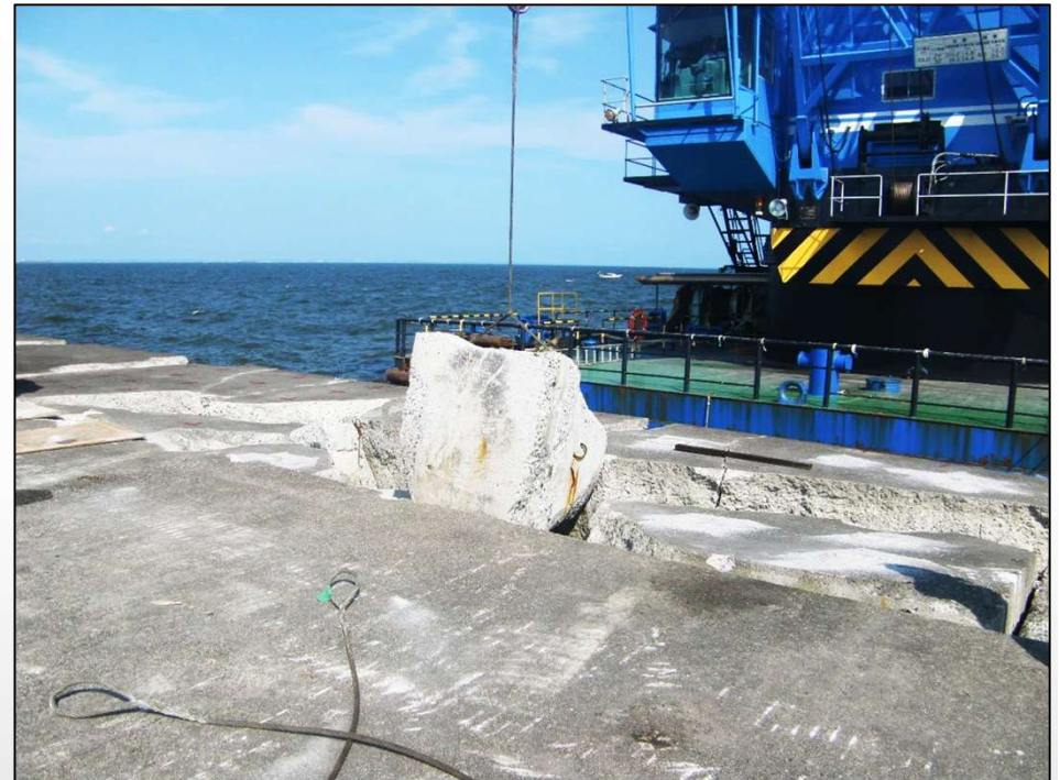
クレーン付き台船での コンクリート撤去状況
