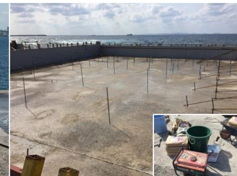
散水湿潤処理
