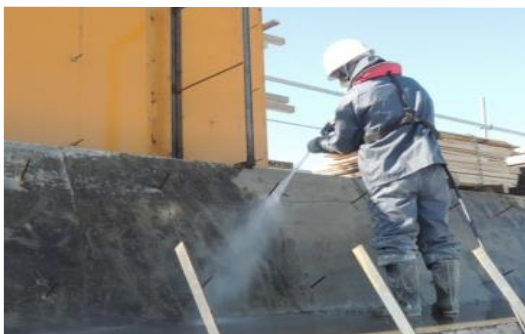
旧コンクリート下地面処理
