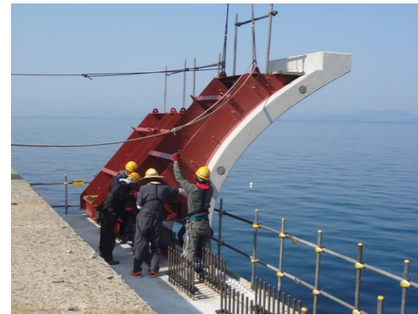
(3) 上部フレアブロック据付
