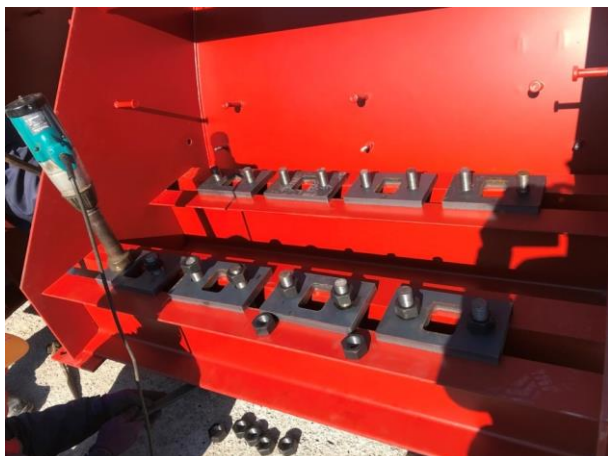
(4) アンカーボルト締付
