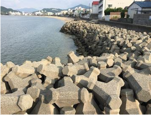
(1)消波ブロック被覆工
