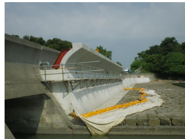
(6) 背後コンクリート打設
