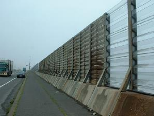
(4)鋼製越波防止柵
