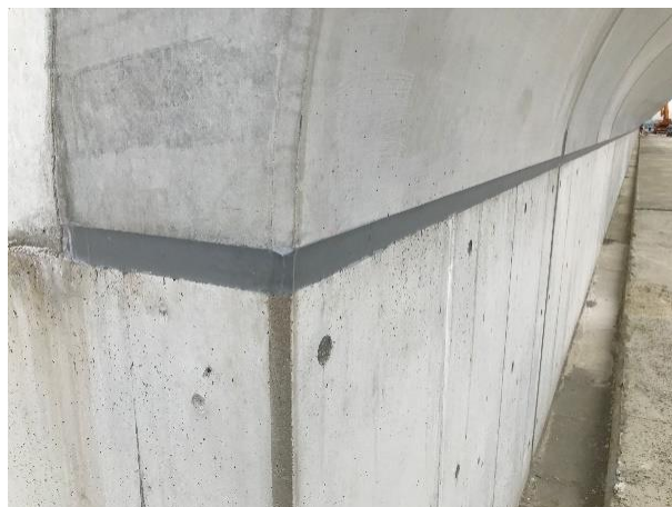
(5) シール剤打設
