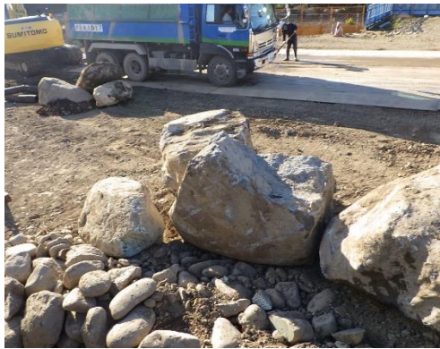
床堀時に確認された転石 推定直径約2m
