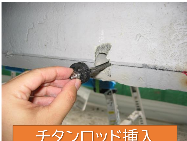
陽極設置孔削孔
