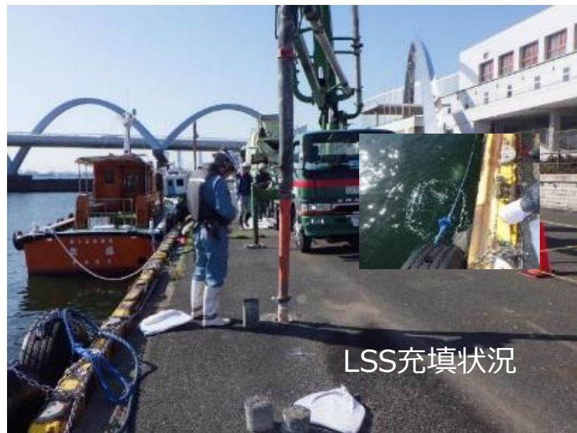
潜水土による LSS流出確認
