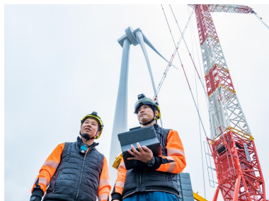
風車建設現場の様子
