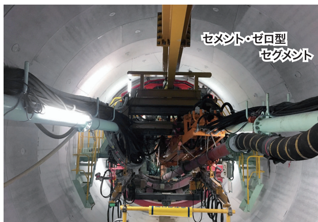
セグメント現場設置
