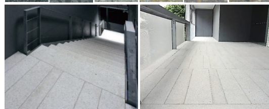
外階段、エントランスへの適用
