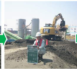
仮置土砂投入
