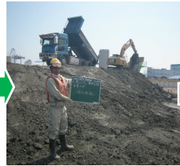
仮置土砂荷卸し
