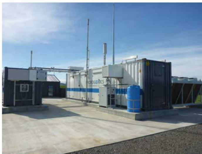
水素製造装置 (ガス圧縮機、水電解装置、放熱器)
