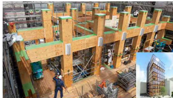
高層純木造耐火建築物
