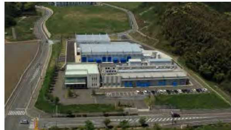
水素エネルギー製品研究試験センター 2期 (福岡県、2014年)
