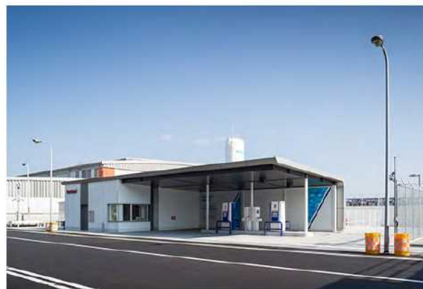
イワタニ水素ステーション関西国際空港 (大阪府、2017年)
