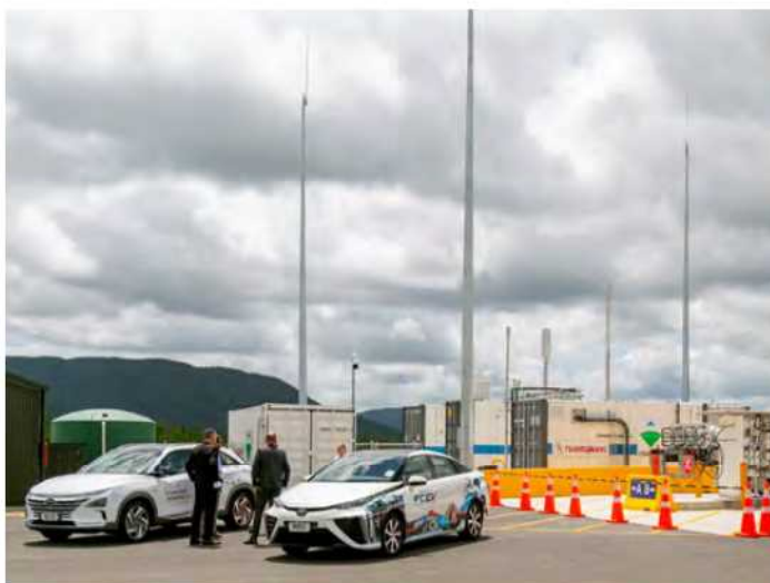
水素製造プラント全景
