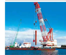
テーパード杭打設の様子
