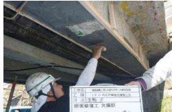
②断面修復部
