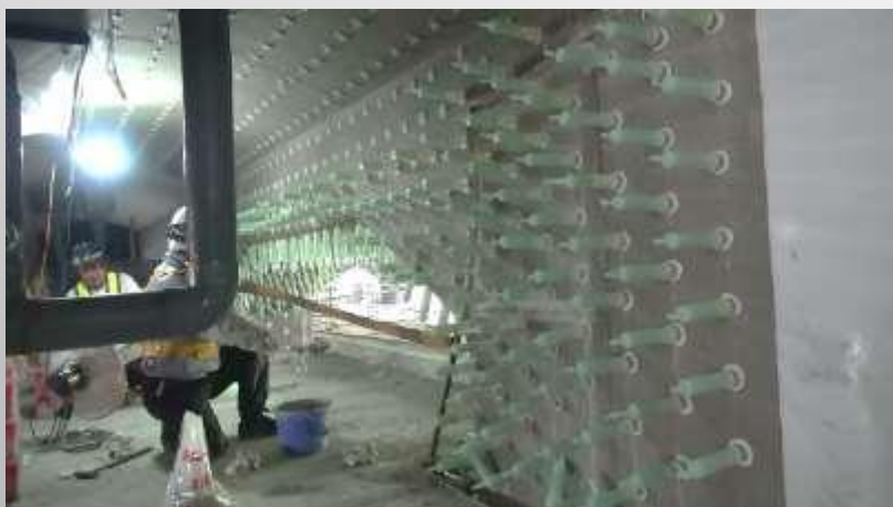
③穿孔→台座取付→注入
