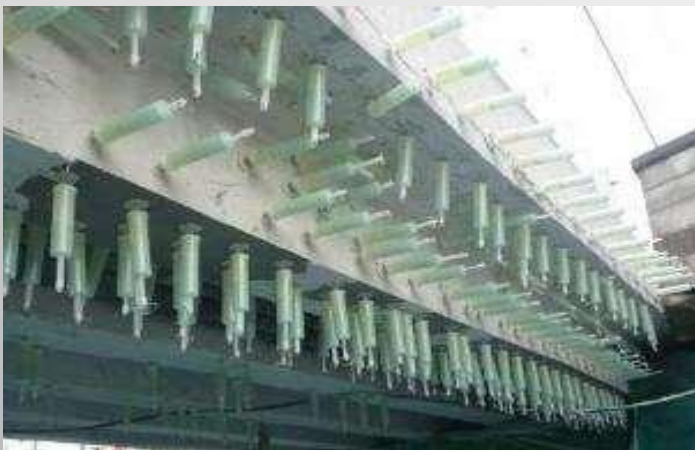
③穿孔→台座取付→断面修復注入
