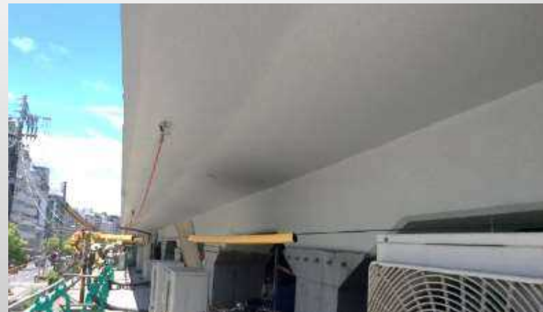
④保護ライニング後完了
