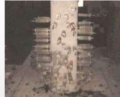
3 IPH樹脂注入
