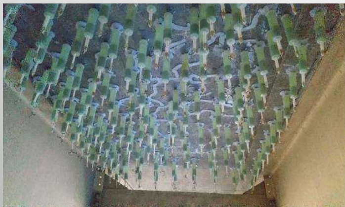
注入加圧養生
