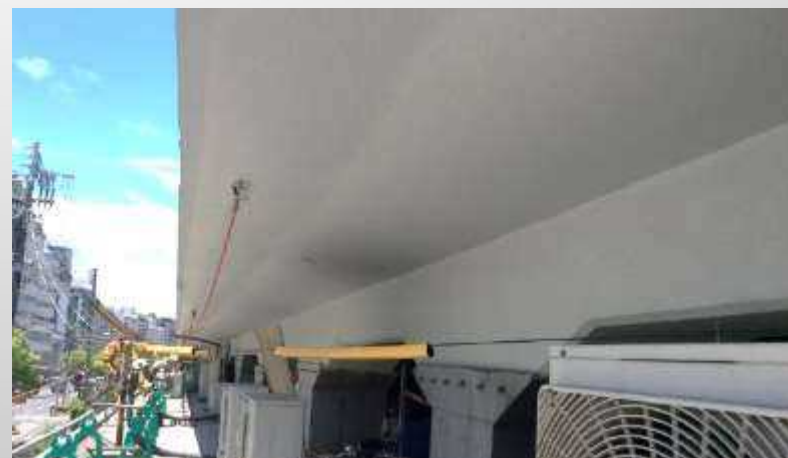
④保護ライニング後完了
