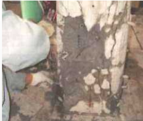
2 欠損部の補修
