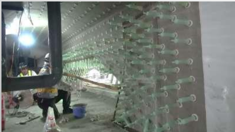
③穿孔→台座取付→注入
