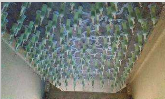
注入加圧養生
