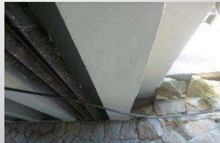
④保護ライニング後完了
