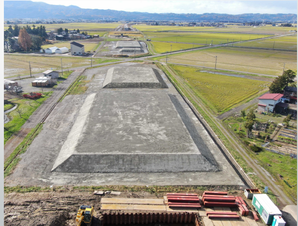
【打設完了整地後状況】
