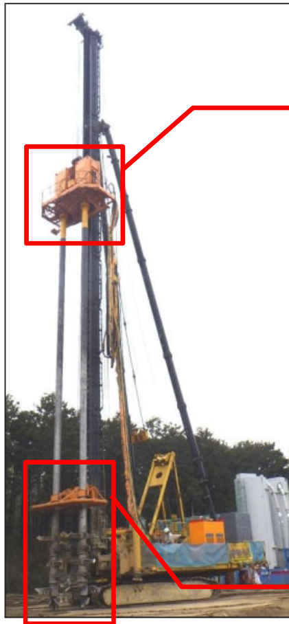
施工状況全景
