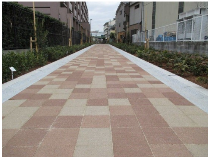
舗装コンクリートブロック
