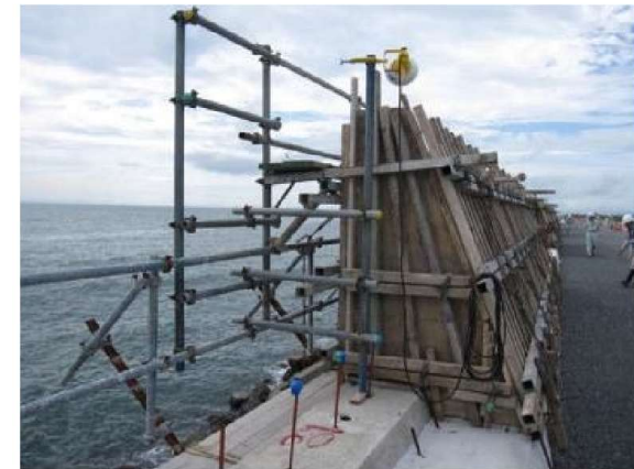
既存護岸の嵩上げ
