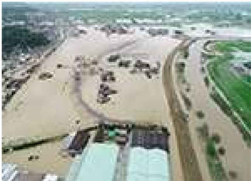
令和元年8月 佐賀県浸水被害
