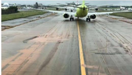
滑走路上の陥没例
