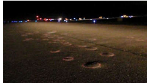
滑走路上の陥没例
