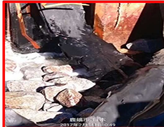
②陥没箇所の損傷防砂板
