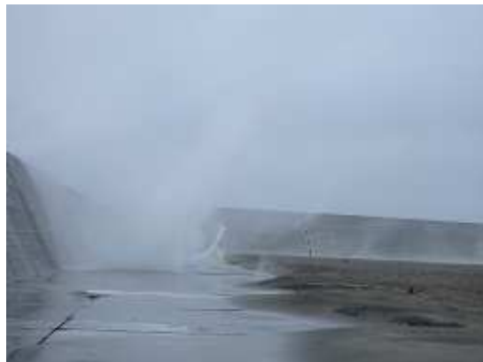
①陥没箇所の波浪状況
