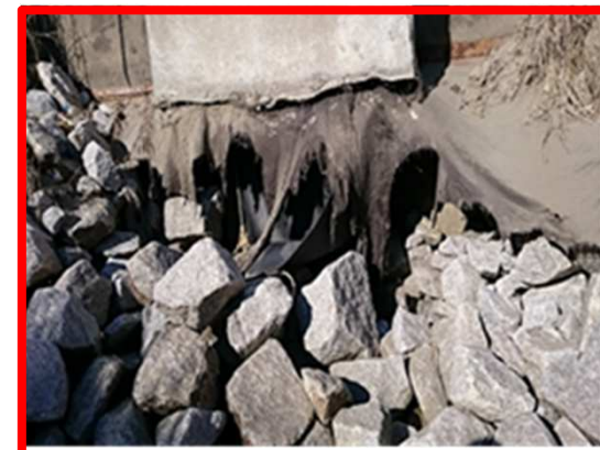
③陥没箇所の損傷防砂シート
