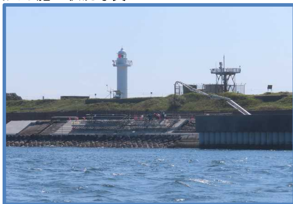
上部工施工状況
