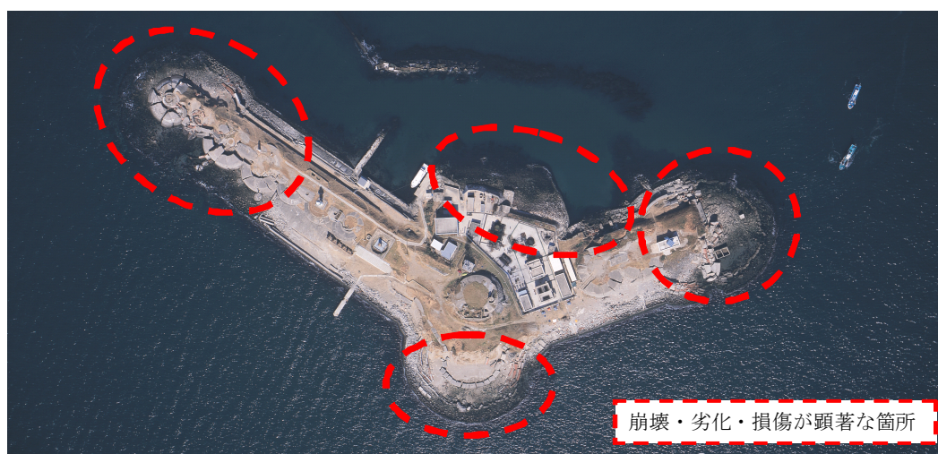
図-2.6.2 主な崩壊箇所
