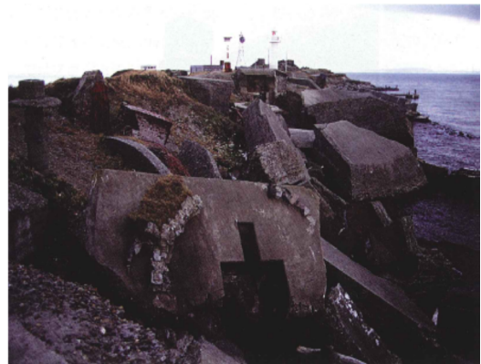
写真-2.6.4 西側地区護岸状況(2002)
