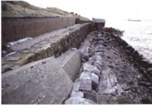
写真-2.6.1 北側地区護岸状況(2002)
