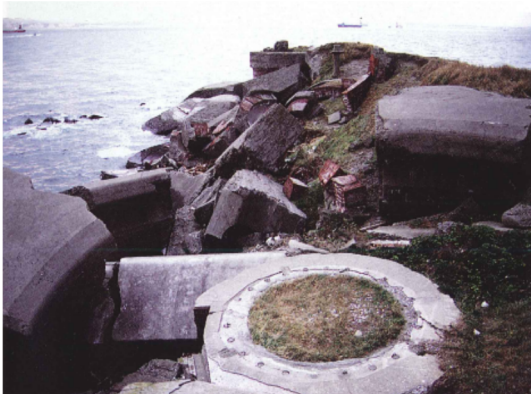
写真-2.6.3 西側地区先端部状況(2002)
