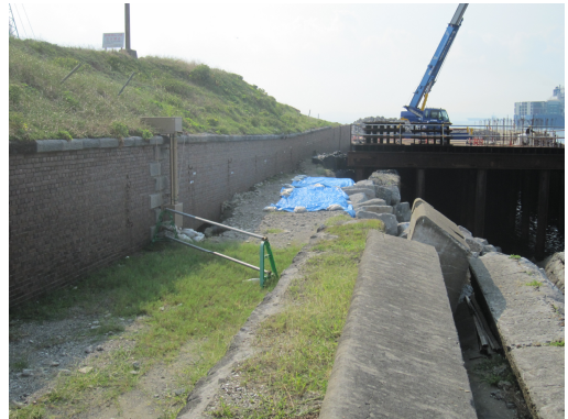
写真-2.6.2 北側地区護岸状況(2013)
