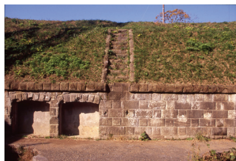
千代ヶ崎砲台
