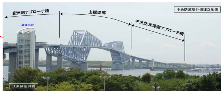
写真:東京ゲートブリッジ(若洲側より)
