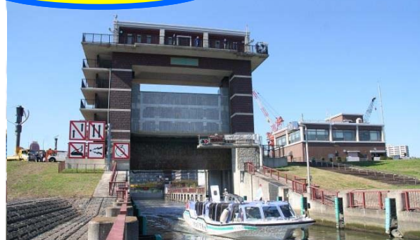
荒川ロックゲート
