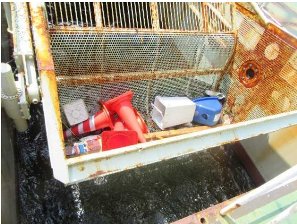
スキッパーによる回収作業
