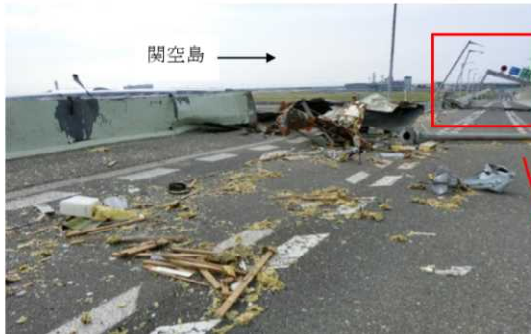
図8 漂流船舶の関西国際空港連絡橋への衝突事故状況(1) (平成30年 台風第21号) (橋の損傷状況)
