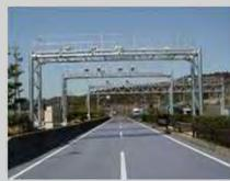
WIM(自動計測装置)による取締り
