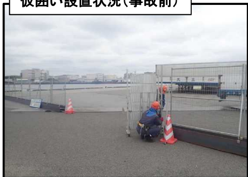
仮囲い設置状況(事故前)
