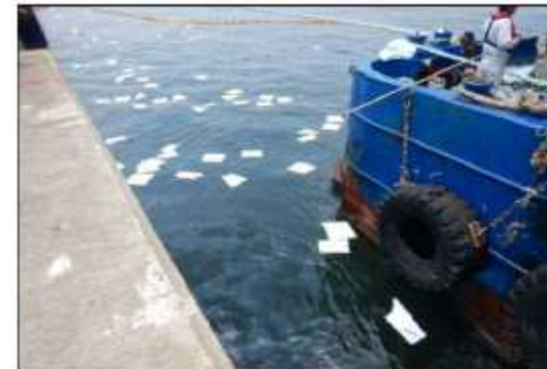
オイルフェンスの展張・吸着マットによる流出油の回収
