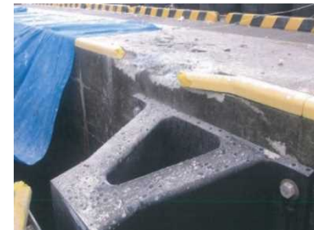
上部工・縁金物 2.0m損傷
