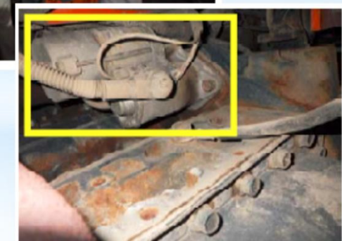
故障部位（セルモーター）
