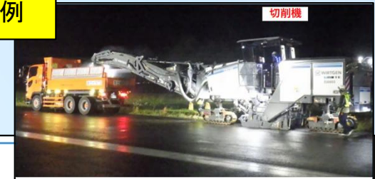
切削機による切削状況（同型機の別日施工状況）
