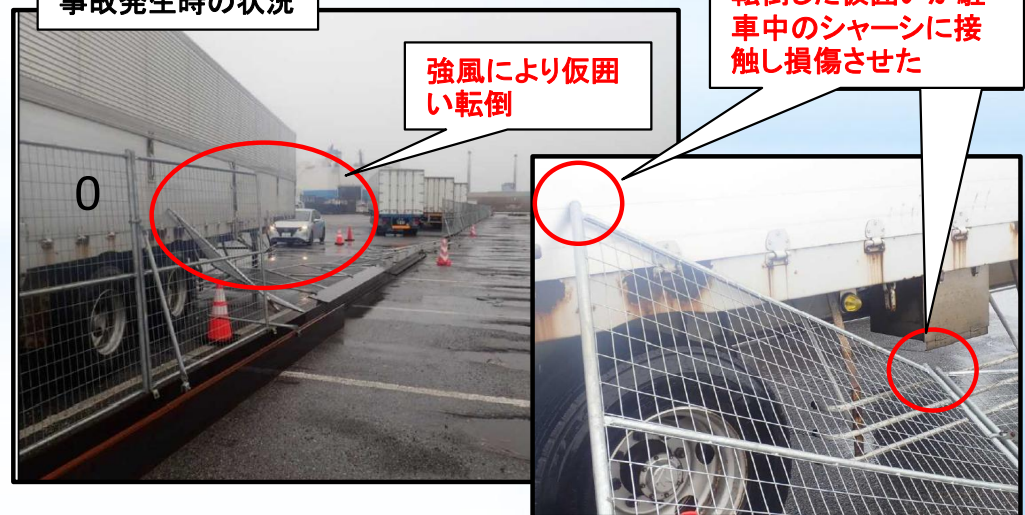
事故発生時の状況
