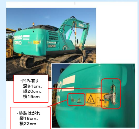
バックホウ損傷状況
