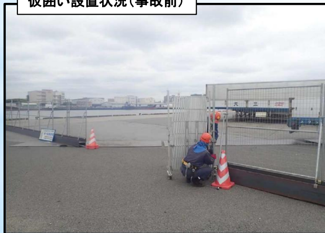
仮囲い設置状況(事故前)
