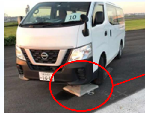
仮設灯火損傷状況
