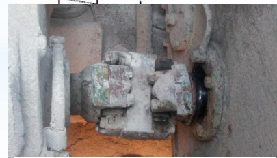
ギアボックスシャフト破断
