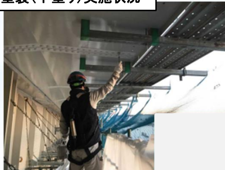
塗装(下塗り)実施状況
