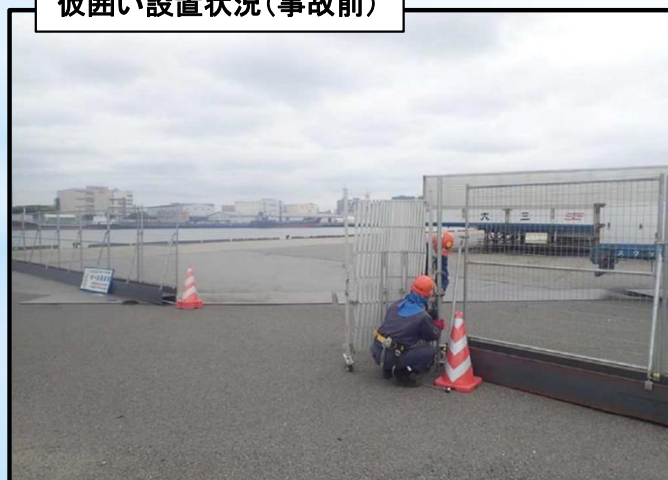
仮囲い設置状況(事故前)
