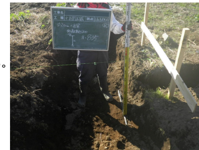
【試掘による確認】
