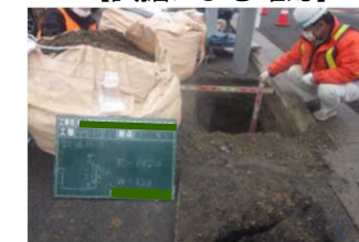
【試掘による確認】
