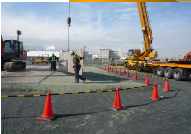
液状化した地盤を整地後、敷鉄板を敷設
