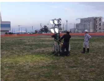
投光機設置状況
