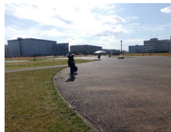
航空灯火設置状況
