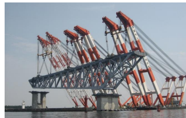
■国内最大の起重機船三隻での相吊架設
