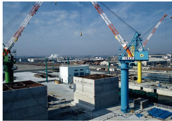
■石巻ケーソンヤード
