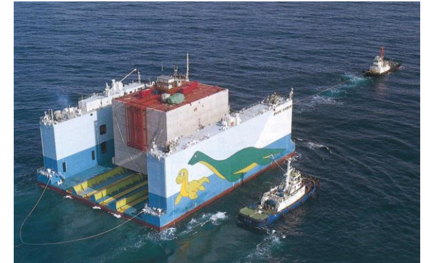
■DCLによるケーソンの回航・据付
