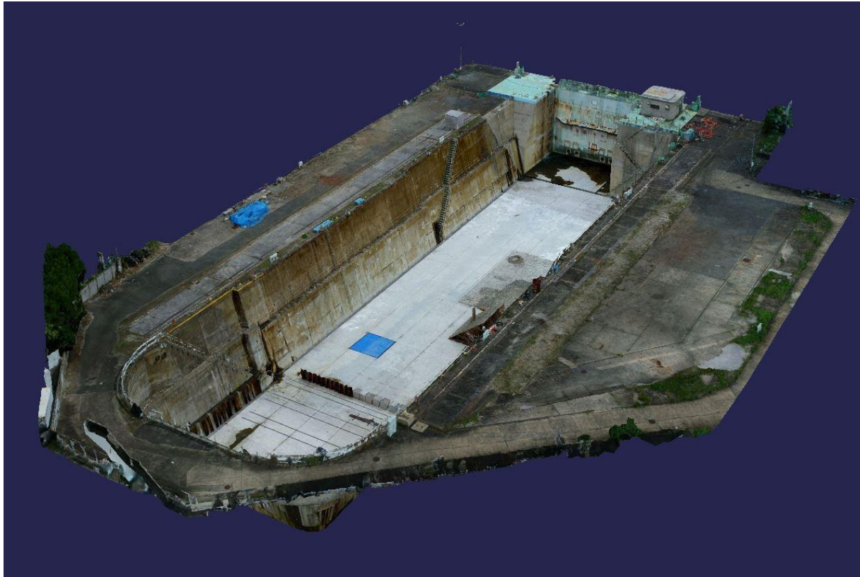
■ドローン撮影により作成した3Dモデルの京浜港ドック
