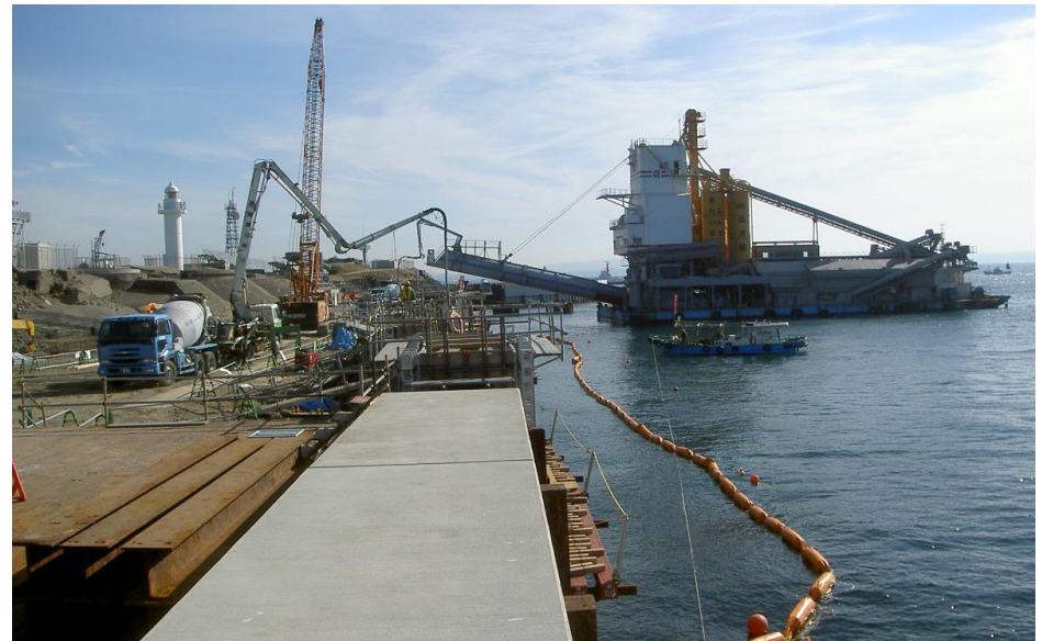
■コンクリートプラント船による打設状況
