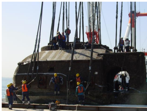
■台船に引き揚げられた大型構造物
