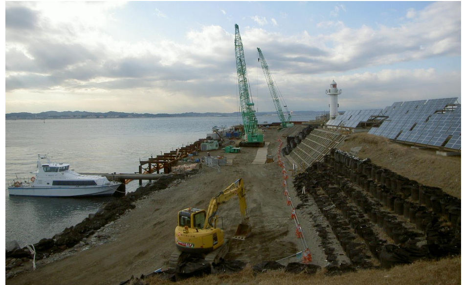
■資材置場も極めて少ない狭隘な作業ヤード
