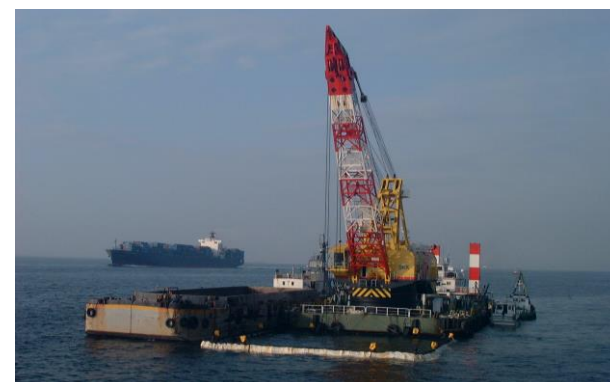
■航路内での浚渫作業
