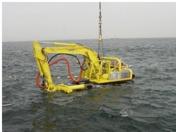
■水中バックホウによる露出調査
