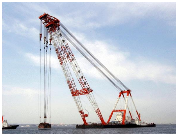
■吊り金具による大型起重機船の撤去
