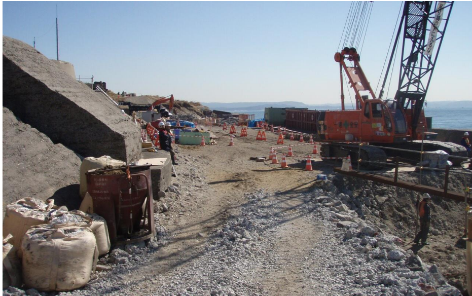
■重機移動に必要な仮設道路整備
