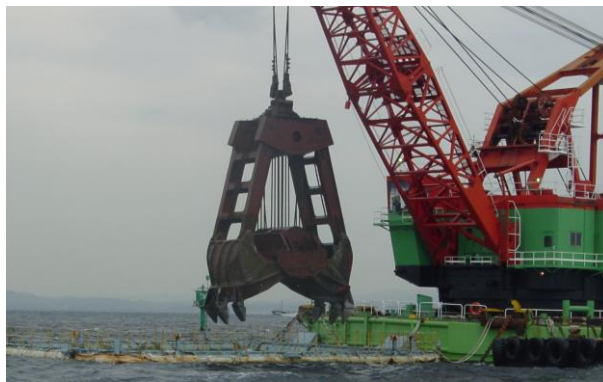
■硬土盤グラブによる撤去作業
