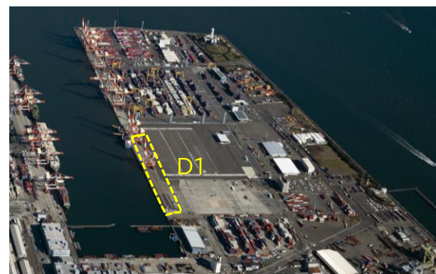
■岸壁完了後(供用前)
