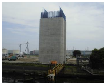
■ニューマチック工法 (MP1 橋脚下部)
