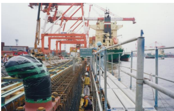
■上部工施工状況
