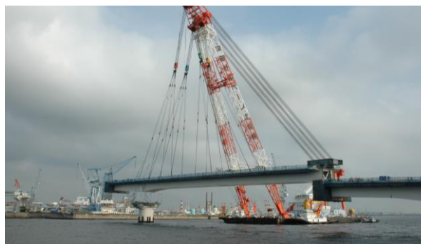
■上部架設(海上部)
