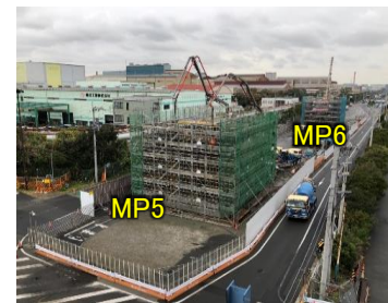
■ニューマチック工法 (MP5・6 橋梁下部)
