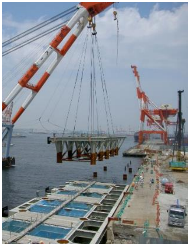
■D1 バースジャケット据付状況
