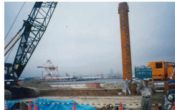
■本体工施工状況
