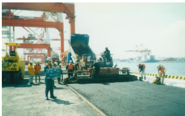
■舗装工施工状況
