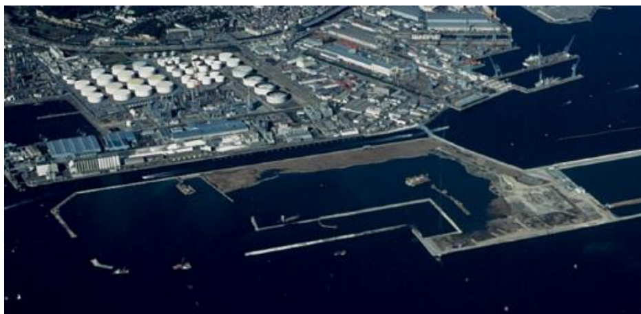
■MC-1 パース施工状況
