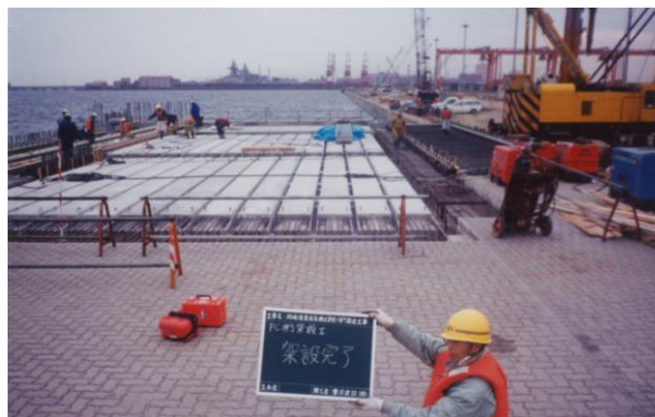
■主桁工施工状況
