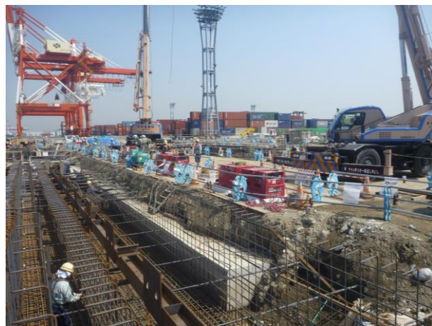
■上部工施工状況
