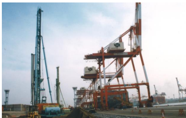
■地盤改良工施工状況
