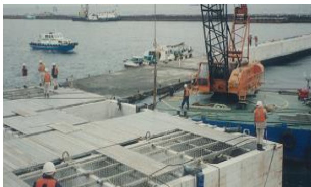
■MC-1 パース施工状況
