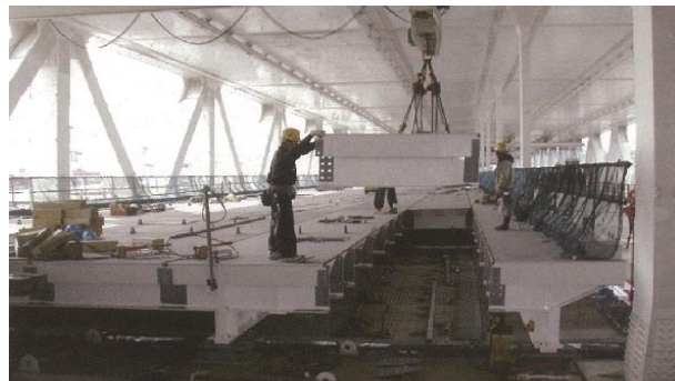
■鋼床版組立状況
