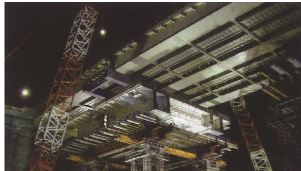
■桁架設状況(本牧側)
