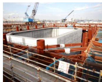
■鋼管矢板井筒工法 (MP3 橋梁下部)
