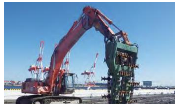
■表層改良施工状況
