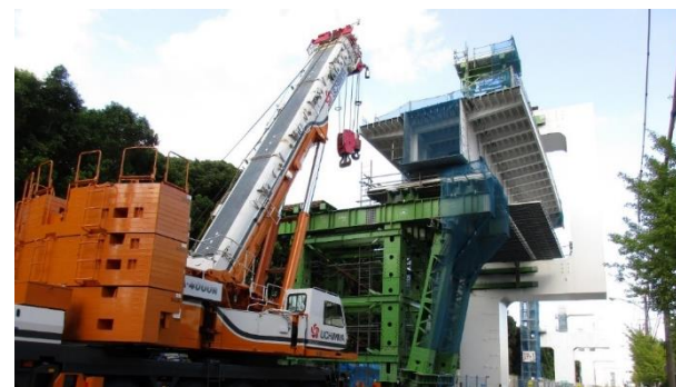
■上部架設(陸上部)
