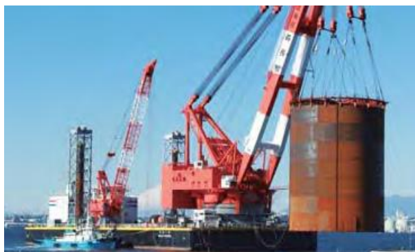
■鋼板セル据付施工状況
