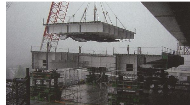
■箱桁組立状況(大黒側)
