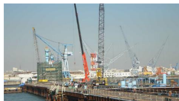
■海上部橋脚(ニューマチックケーソン)
