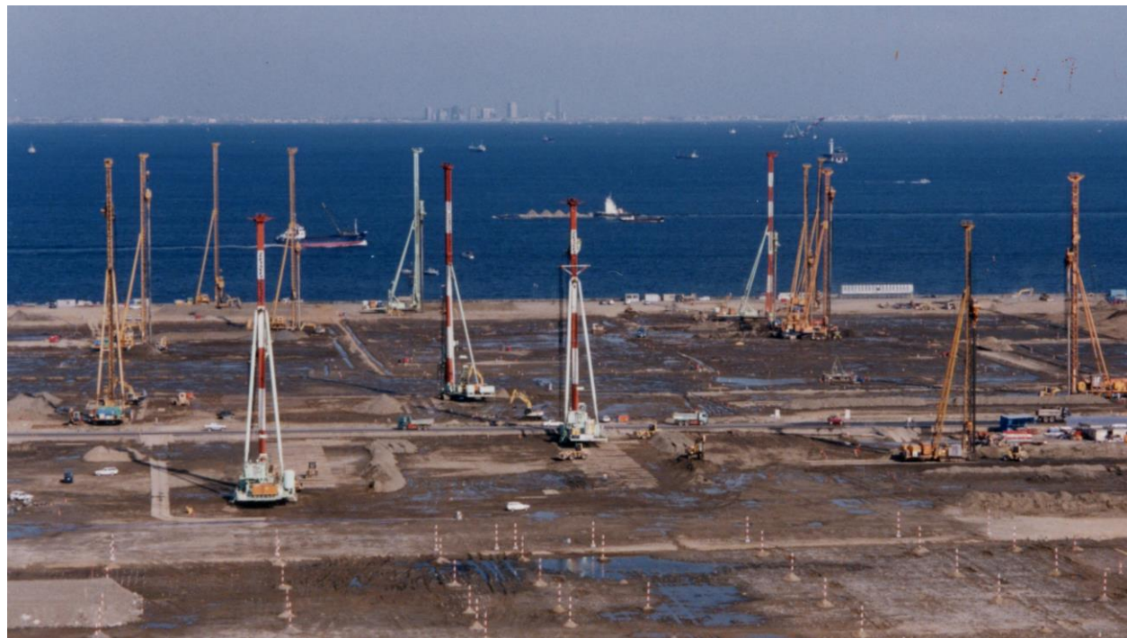
■Ⅲ期地区の地盤改良(ペーパードレーン) 写真提供/ドウ・アーバン
