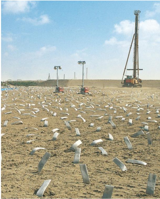
■ I 期地区のペーパードレーンによる地盤改良
