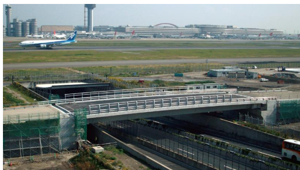
■GSE橋梁(2008(平成20)年9月)
