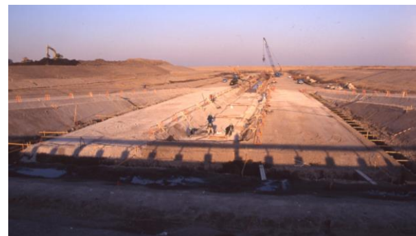
■照明共同溝工事 写真提供/ドウ・アーバン
