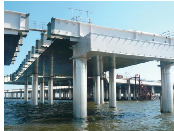
■ 栈橋・連絡誘導路接続部 写真提供/羽田再拡張D 滑走路JV
