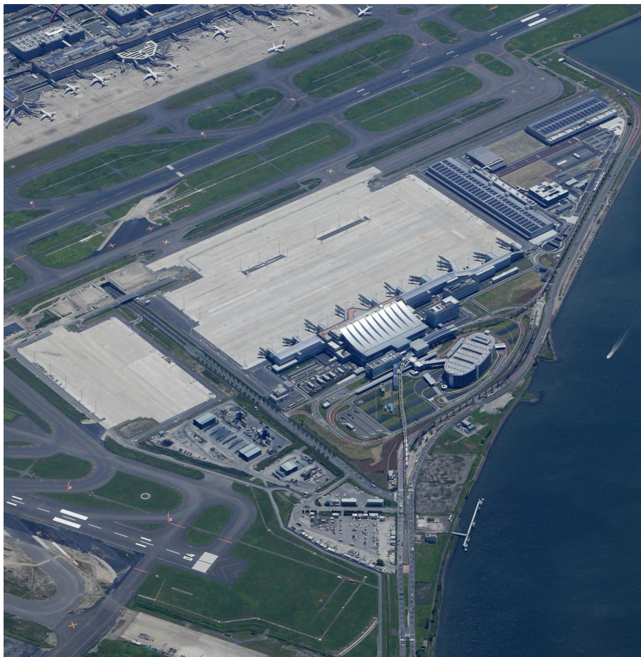
■概成した国際線地区(2010(平成 22)年 7 月)
