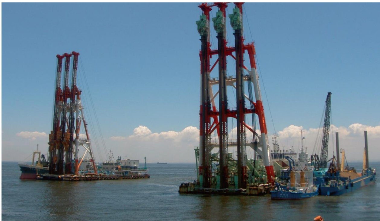
■埋立部の地盤改良(サンドコンパクションパイル船)
