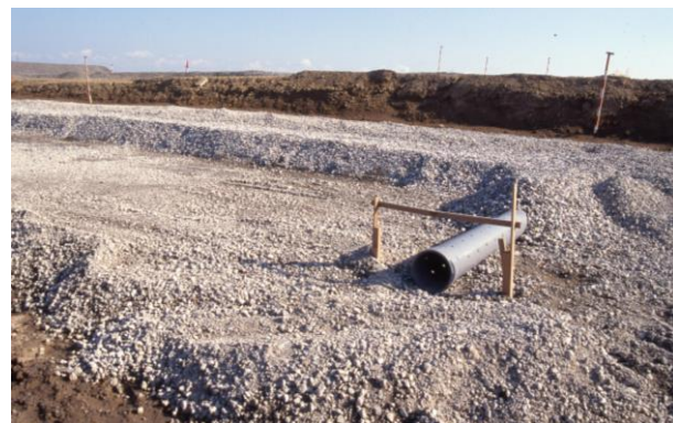
■滑走路に設けた排水層 写真提供/ドウ・アーバン
