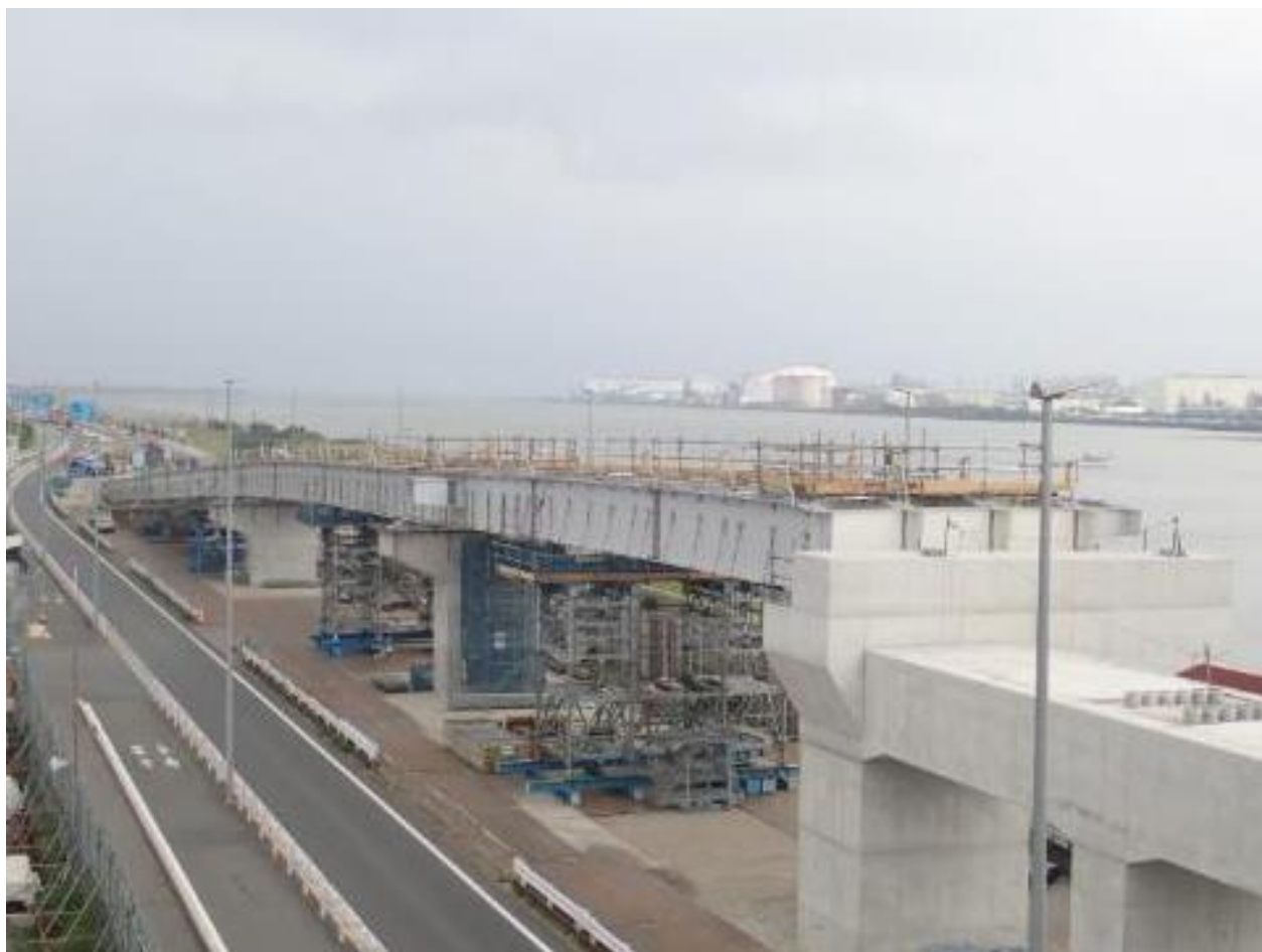
■羽田連絡道路環八ランプ部工事状況
