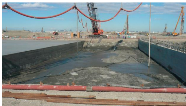
■既存構造物防護工(SGM工法)
