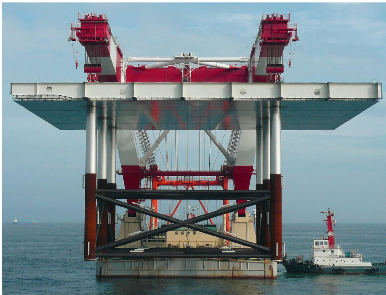
■制限表面を考慮した低頭式クレーンによって吊り上げられたジャケット
