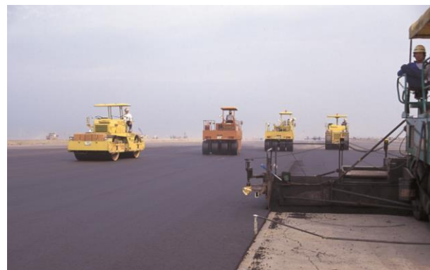
■滑走路の舗装 写真提供/ドウ・アーバン
