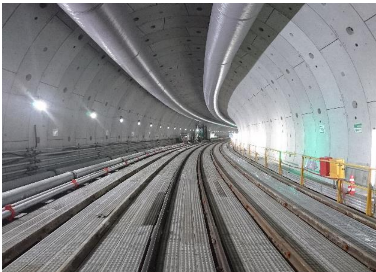
■ 際内トンネルのシールド内
