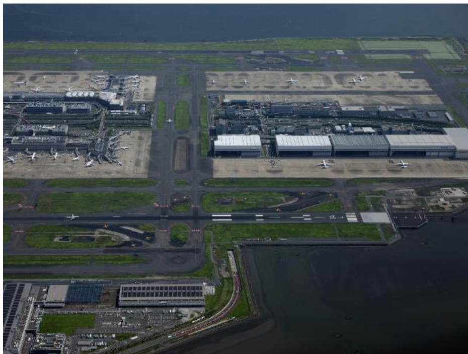
■A・C滑走路高速脱出誘導路の工事
