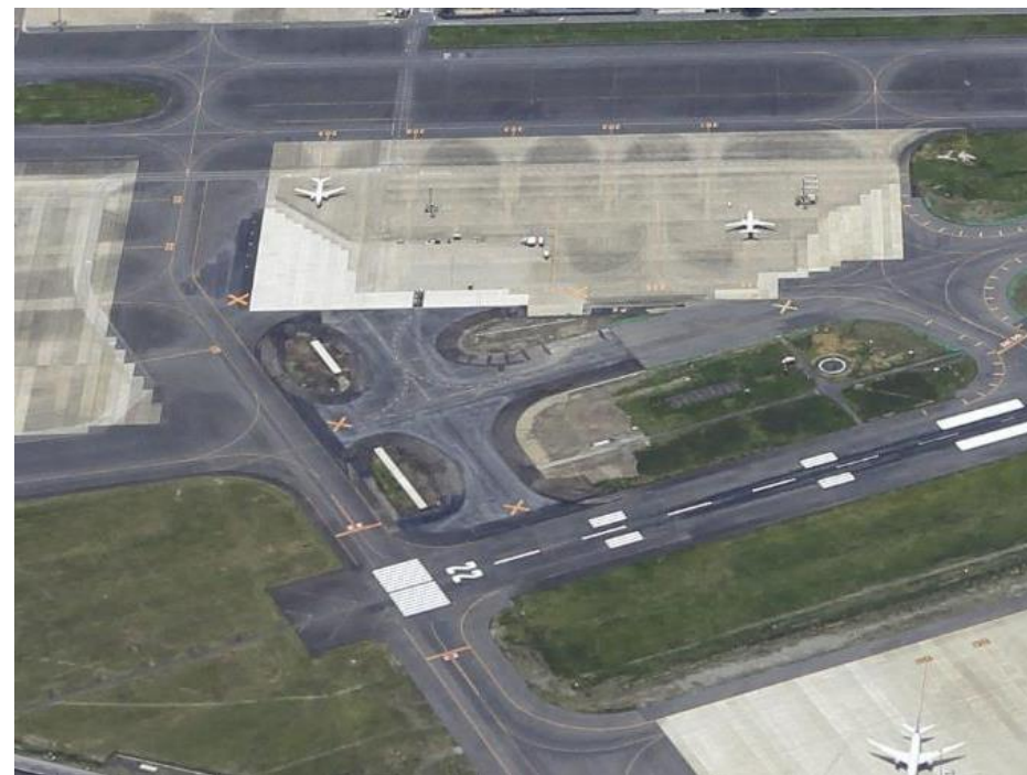
■B滑走路取付・平行誘導路の工事
