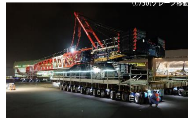
■750t吊クローラークレーン移動台車で移動中
