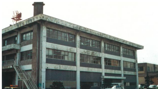
■ Ⅰ期工事実施中の東京空港工事事務所①
