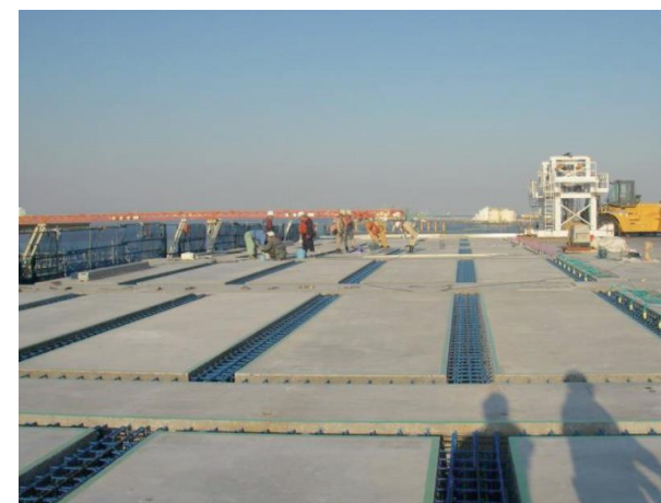
■ 連絡誘導路部のPC床版据付
