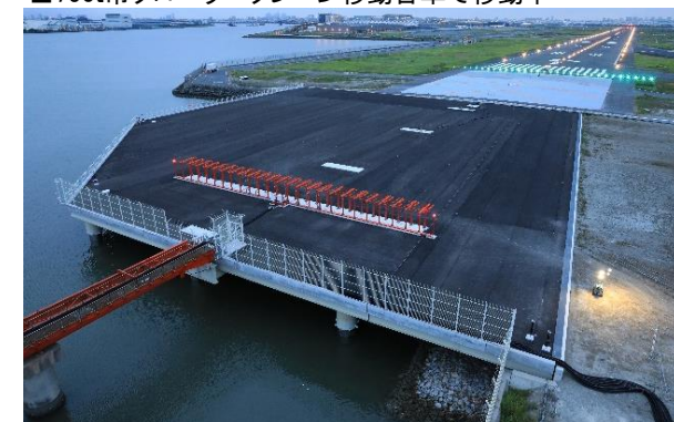
■アレスティングシステム完了後 2019(令和元)年8月 写真提供/大成建設
