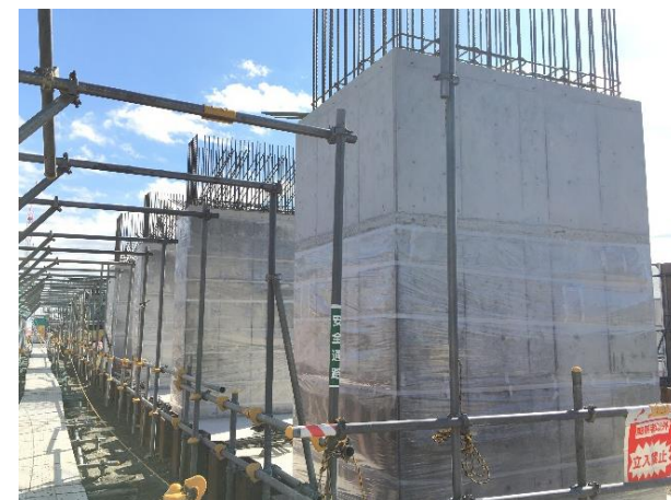
■環八ランプ部下部の工事状況
