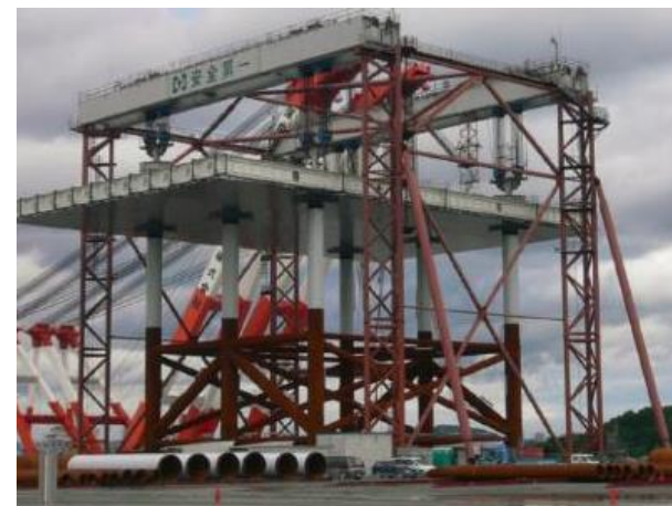
■一体化される上部・下部ジャケット
