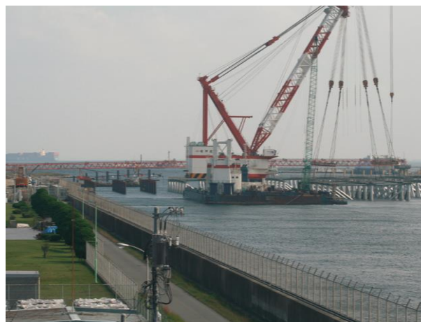
■ 連絡誘導路部の施工
