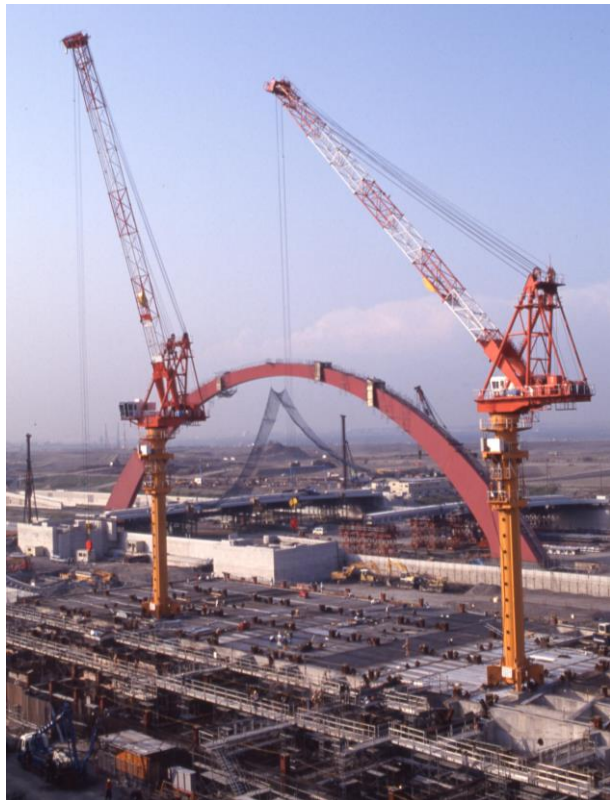
■羽田スカイアーチの施工 写真提供/ドウ・アーバン
