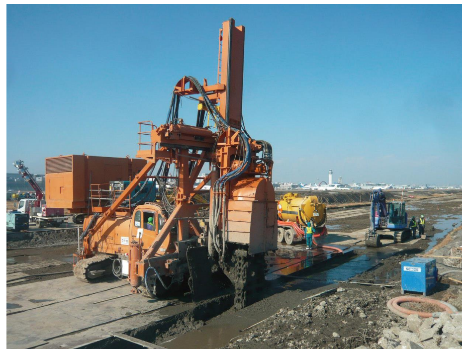
■C滑走路延伸部での連続地中壁工事
