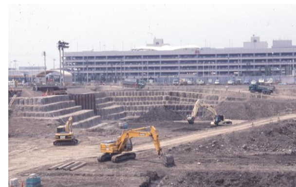
■ 東旅客ターミナル地区共同仮設工事 写真提供/ドウ・アーバン
