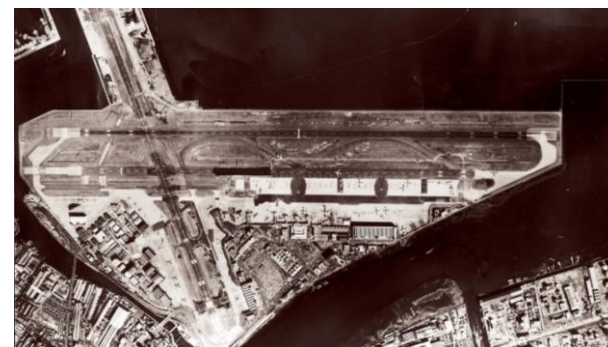
■滑走路を運用しながらの延長工事
