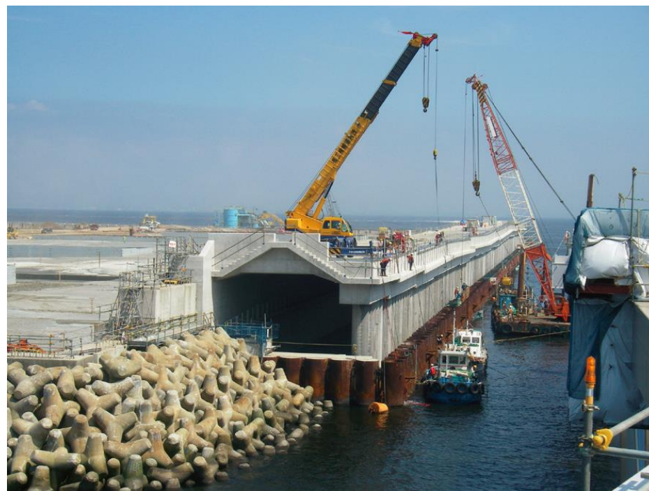
■円形スリット柱による消波護岸
