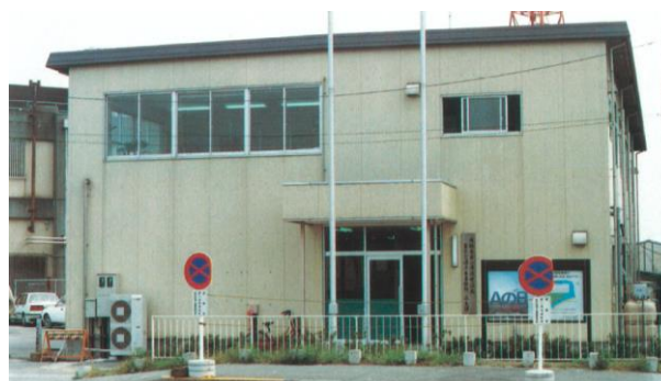
■ Ⅰ期工事実施中の東京空港工事事務所②
