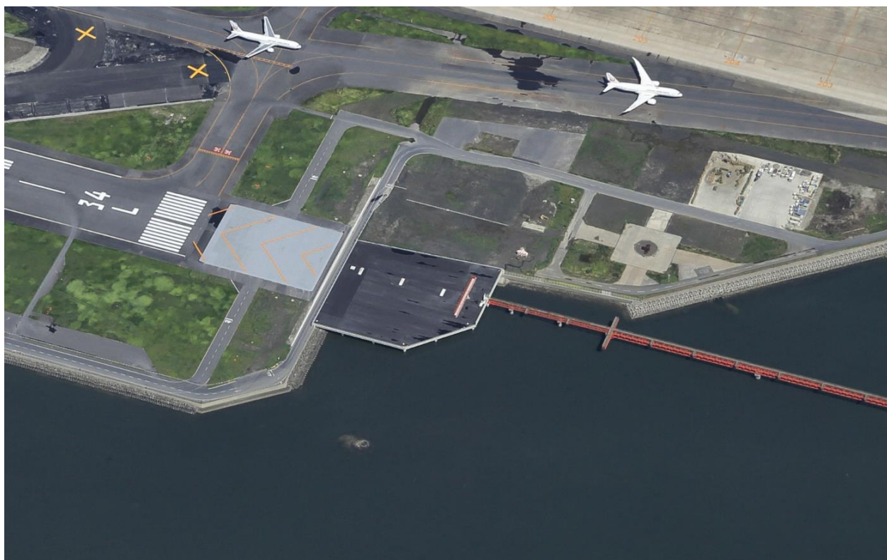
■A滑走路南側航空保安施設用地完了後(2019(令和元)年8月)
