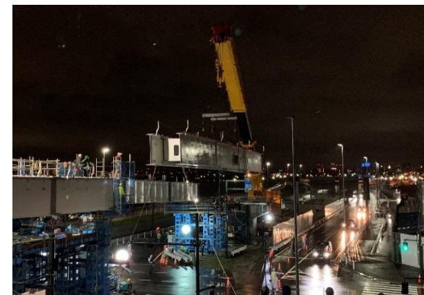
■環八ランプ部上部工架設状況
