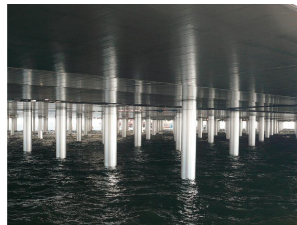
■ジャケット下部に採用された耐海水性チタンプレートと鋼管杭の防食に用いたステンレス鋼ライニング
