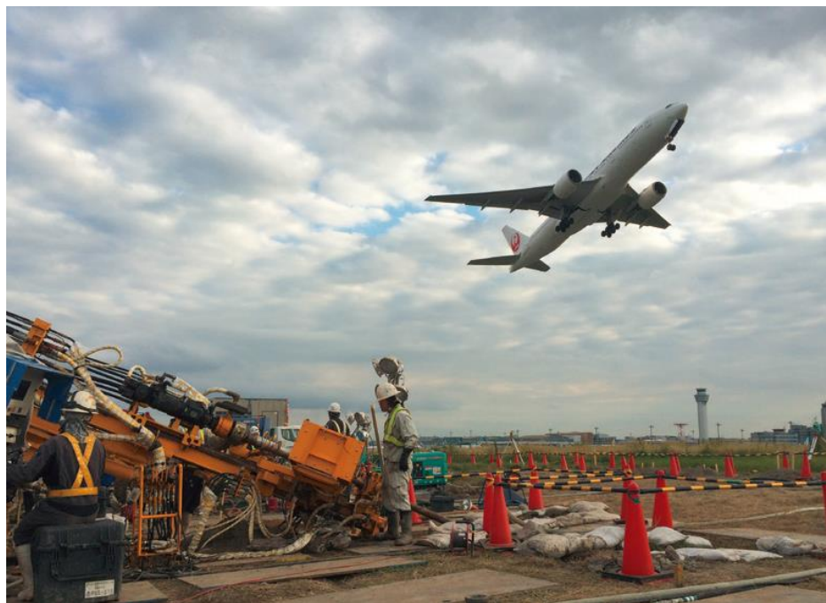
■曲がり削孔による薬液注入工事
