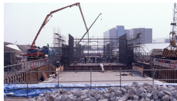
■GSE連絡地下通路工事 写真提供/ドウ・アーバン
