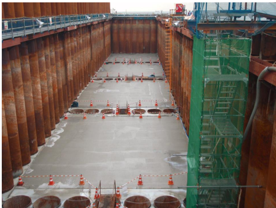
■連続打設した鋼管矢板井筒
