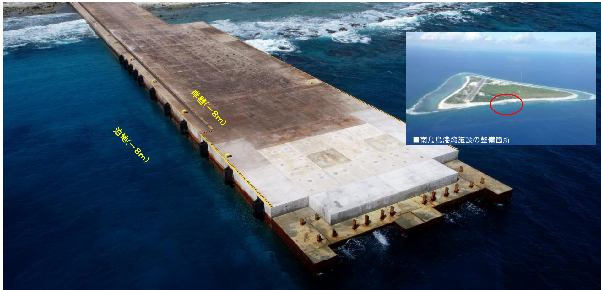
■整備中の南鳥島港湾施設
