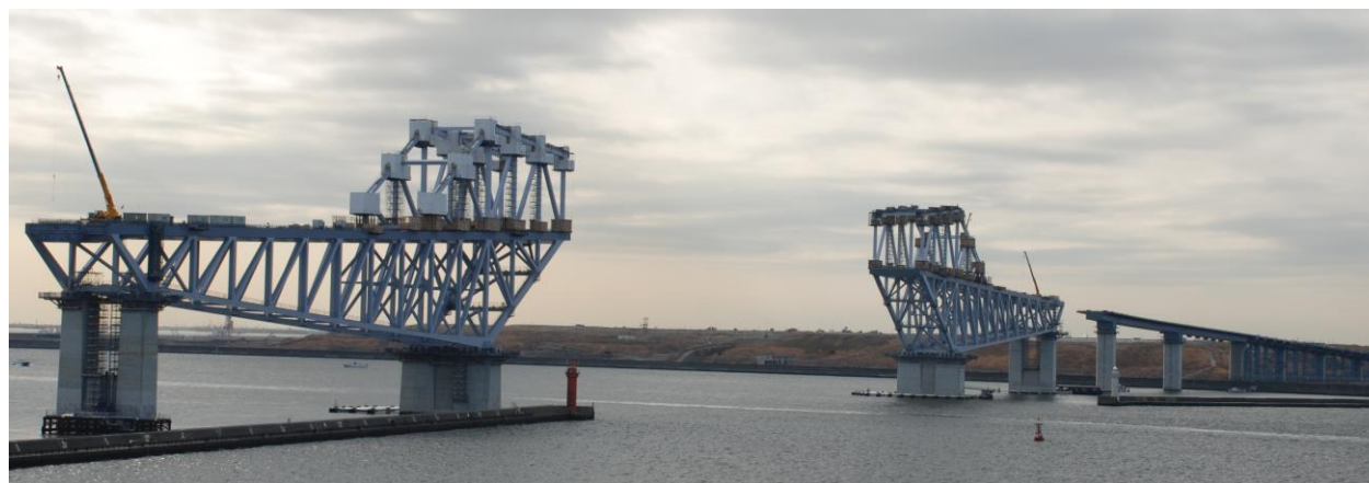
■ 橋梁上部構築状況
