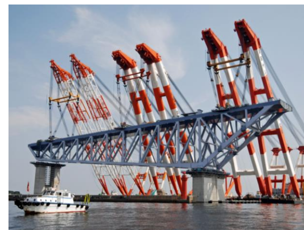
■ 橋梁上部構築状況
