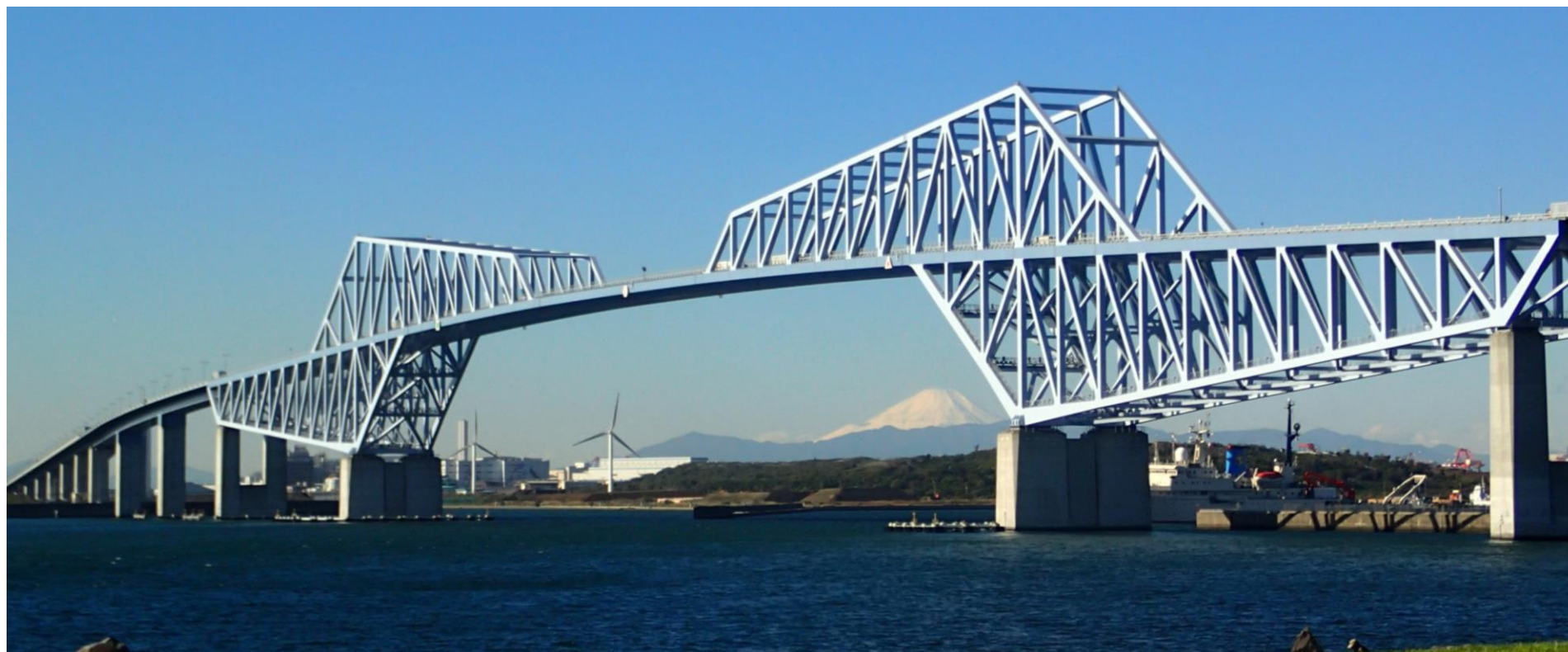
■東京ゲートブリッジ
