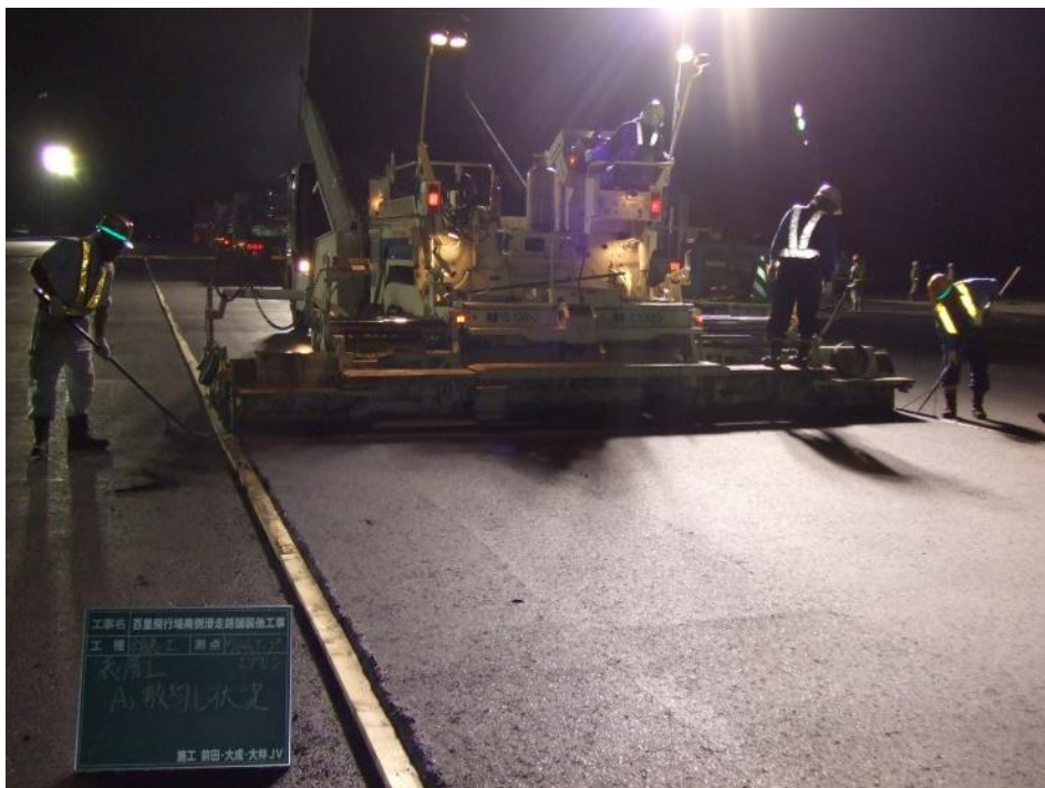
■夜間施工状況
