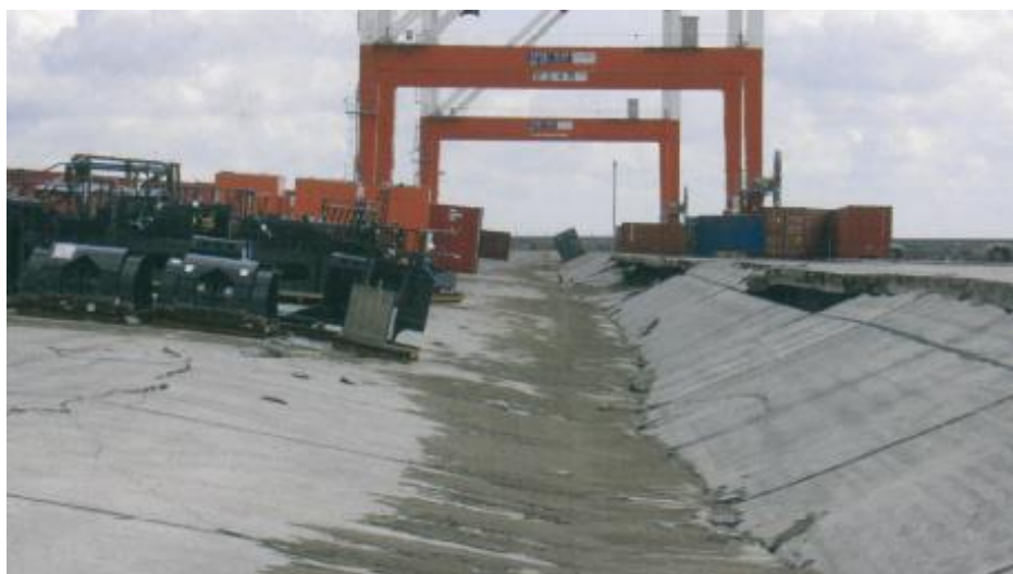
■岸壁(-14m)背後の沈下
