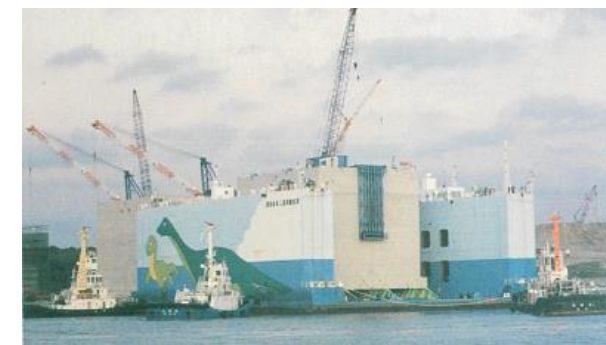
■ケーソン引出し
