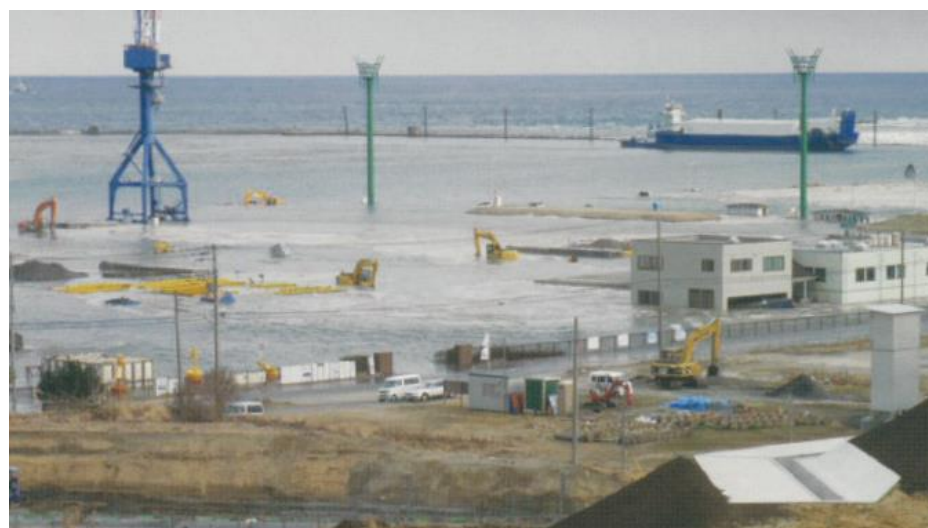
■津波襲来による浸水
